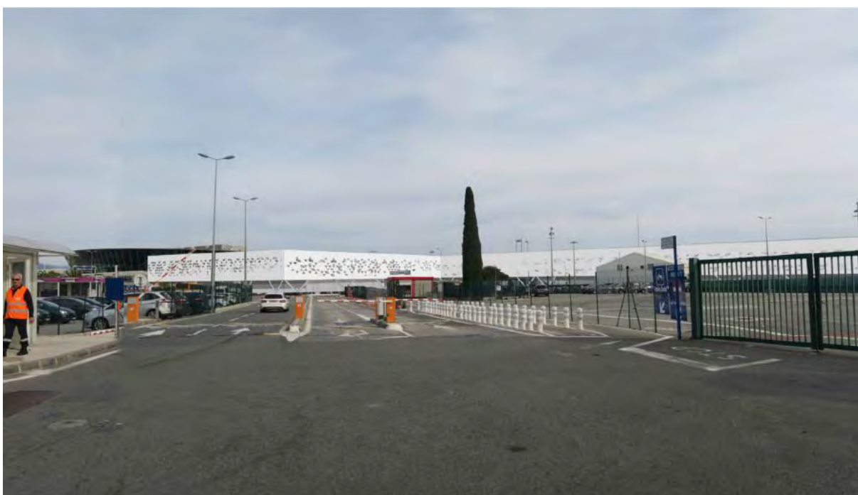
Insertion de l'extension et de la darse en vue lointaine (source : STEPHANE AUREL ARCHITECTURE)
