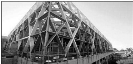
Les travaux, côté Terminal 2, sont déjà en cours.
